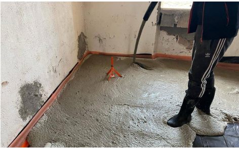
Coulage d’une chape allégée fluide sur un plancher bois
