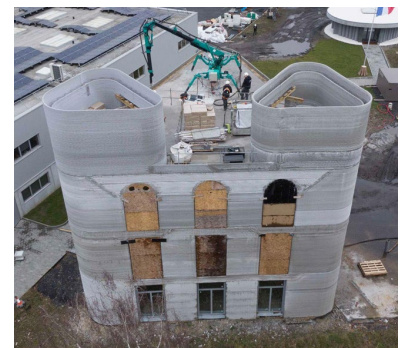
Immeuble en béton 3D
