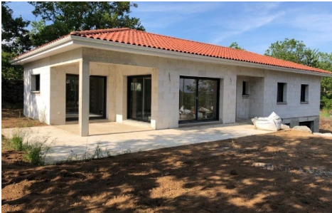
Maison neuve en blocs de béton cellulaire
