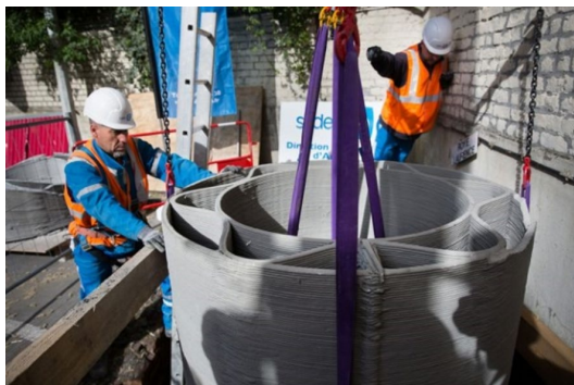
Pose d'un regard en béton 3D
