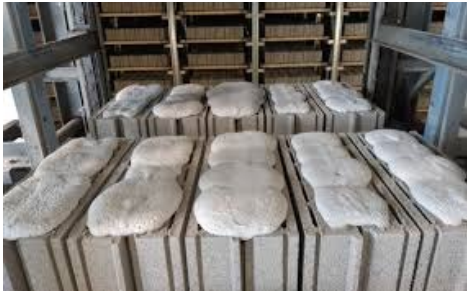
Blocs béton remplis de béton de mousse
