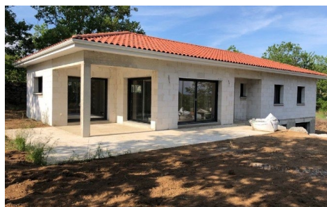
Maison neuve en blocs de béton cellulaire
