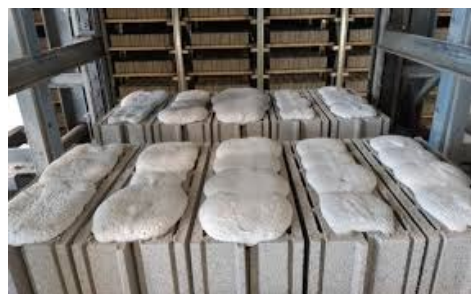
Blocs béton remplis de béton de mousse
